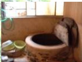
空き缶風呂：空き缶をモルタル製浴槽の骨材として活用
